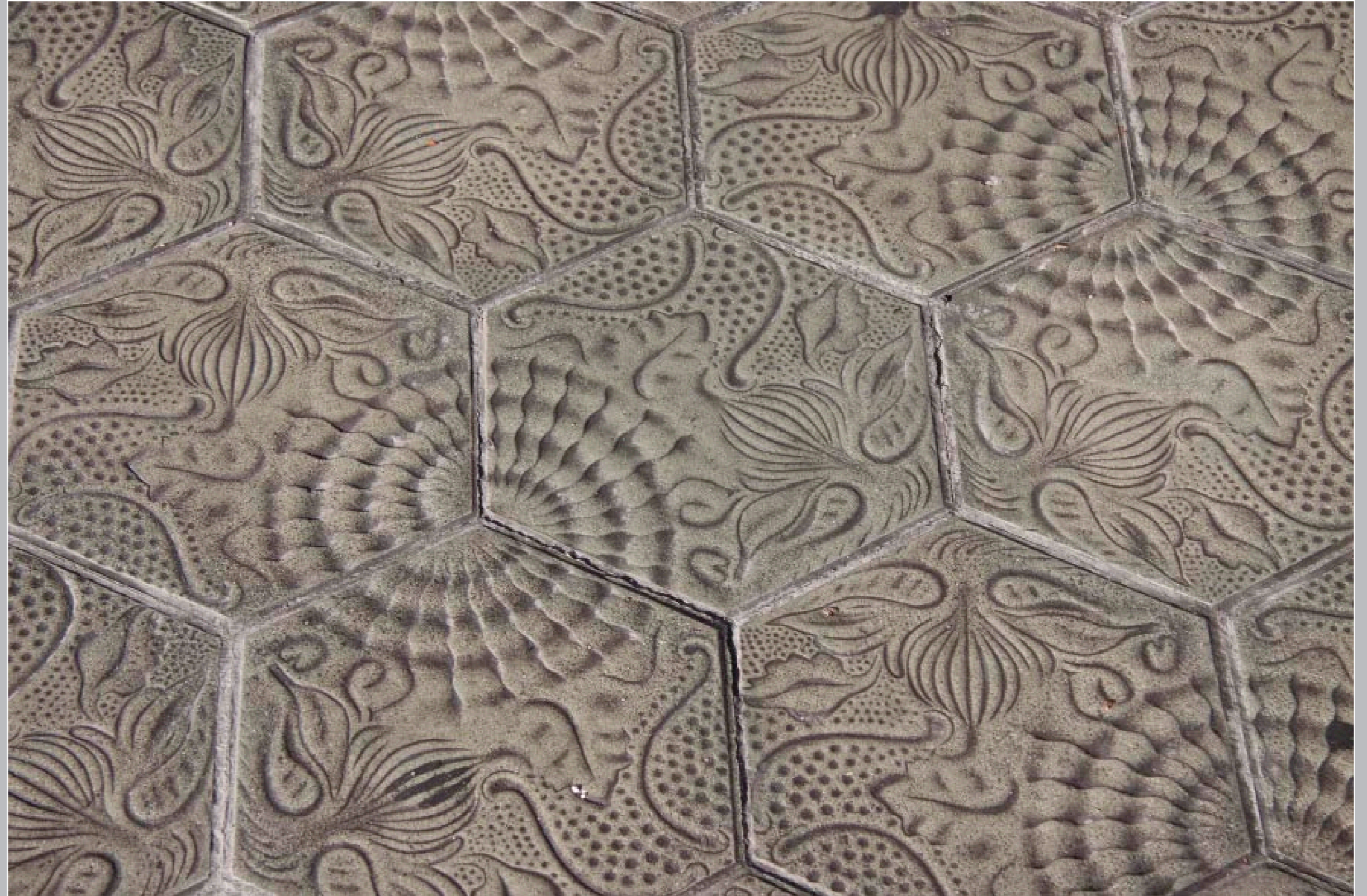
Dlažba na Rambla de Catalunya
