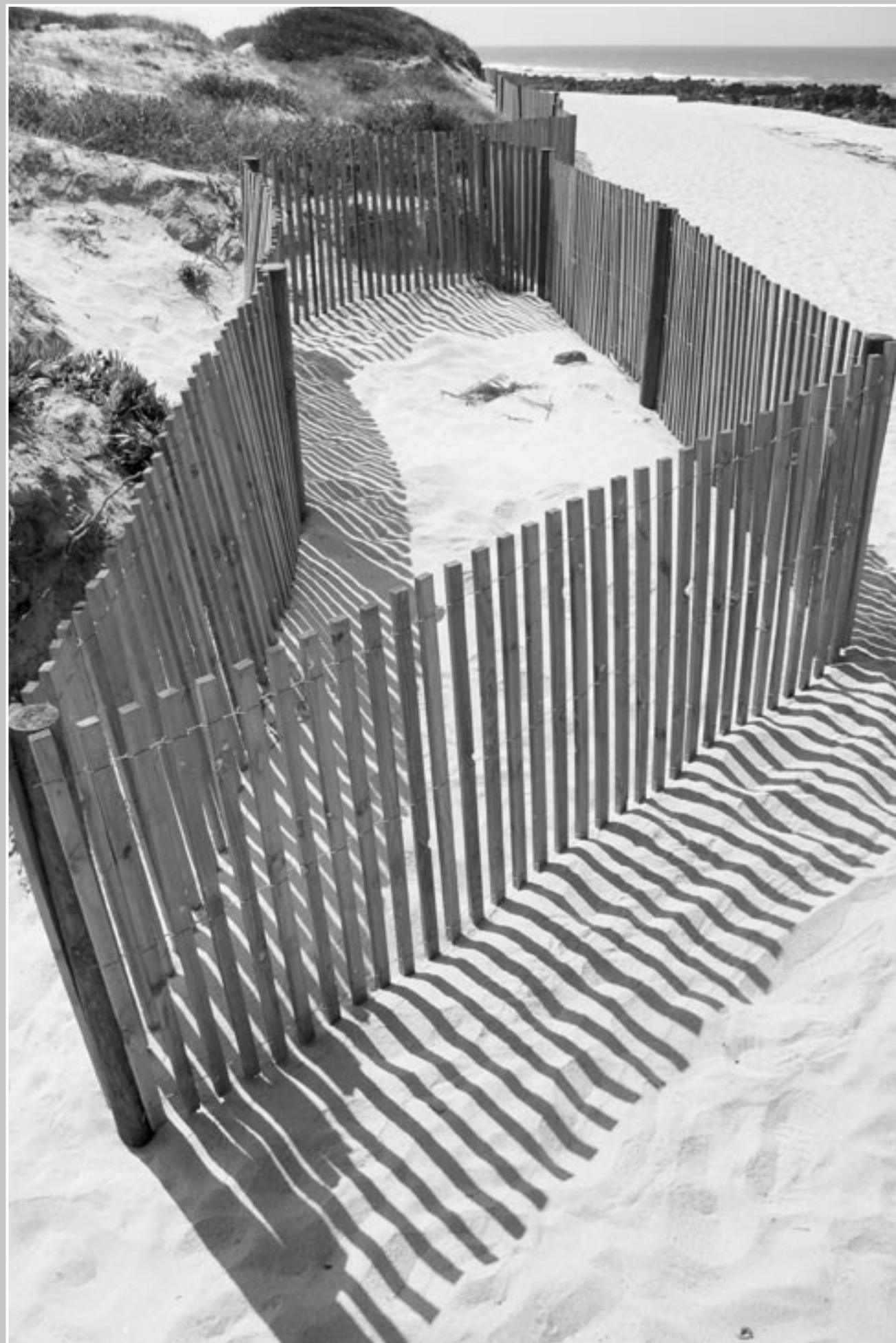
Caminho Portugues da Costa, obrana před pískem 1
